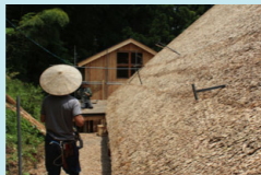
©ちいおりトラスト 屋根の葺き替え作業の様子
